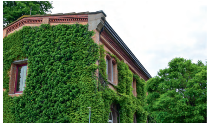
Abb. 4-10: Die begrünte Fassade des Tiefbauamtes der Stadt Ludwigsburg in der Mathildenstraße, ein Standort im Bound „Klima und Energie“ in Ludwigsburg, Abschnitt „von außen grün“.
